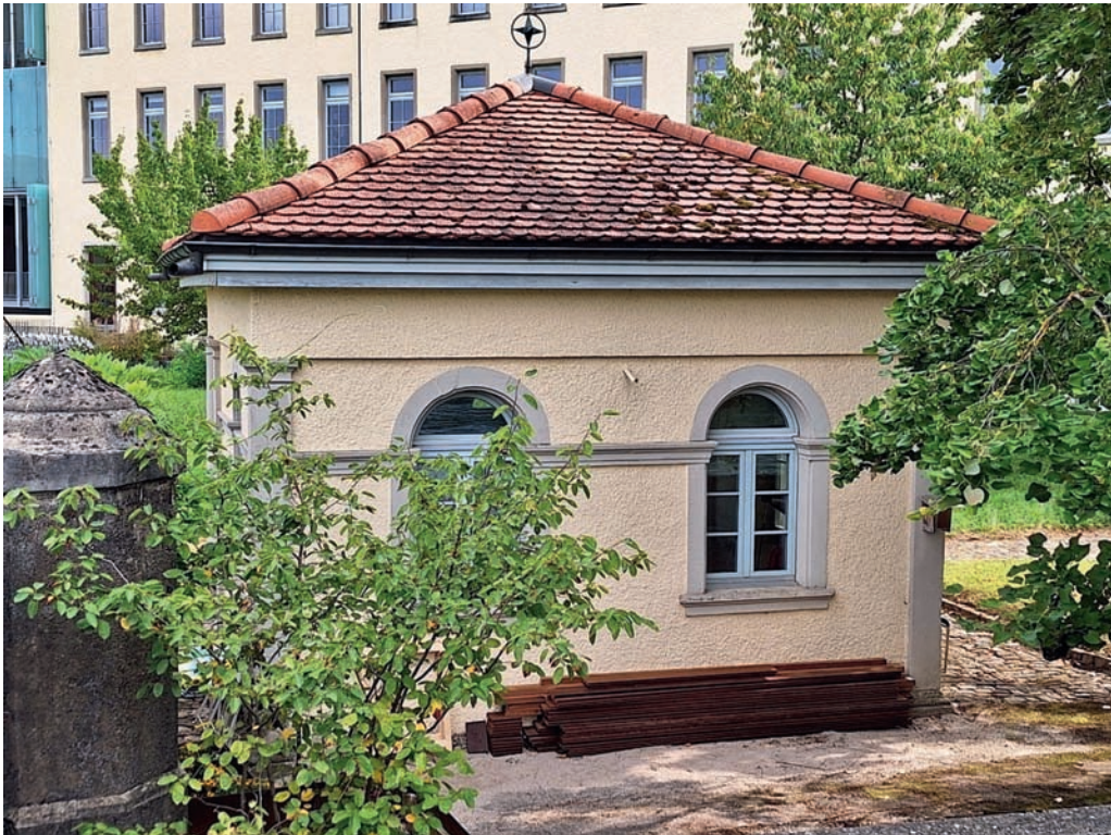
Abbildung 3. Das Fabrikshulhäuschen vor dem Fabrikgebäude der Spinnerei Kunz in Windisch. Foto Peter Belart, Schinznach.
