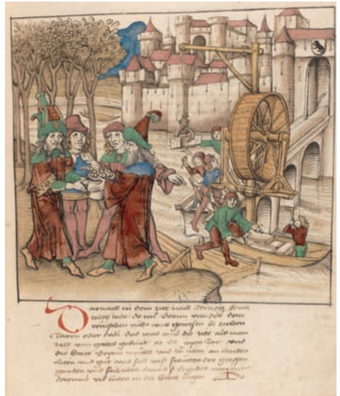
Bau der «Untertorbrücke» in Bern 1255/56. Diebold Schilling, Spiezer Chronik, Bern, Burgerbibliothek, Mss.h.h.I.16, S. 81. 10
